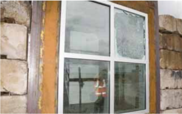
Patlamadan Sonra (Giydirme Cephesi)
